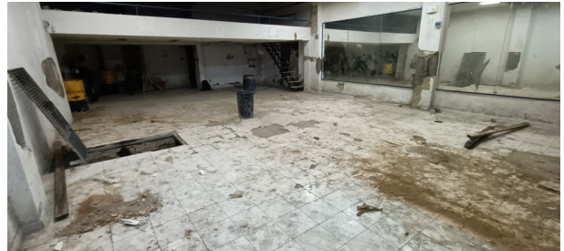
2. Vista general de l'interior de l'edifici
