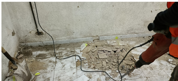
3. Inici dels treballs a la cala 1.
