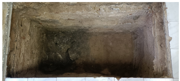
6. Vista general de cota final de Cala 1
