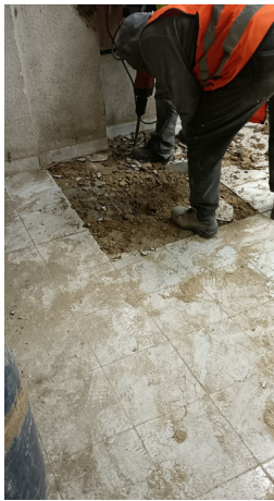
11. Inici dels treballs a la cala 3
