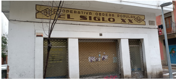
1. Vista general façana de l'edifici
