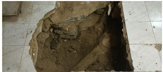
14. Cota final de cala 3 on s'observa fonamentació UE 19 i canalització UE 20
