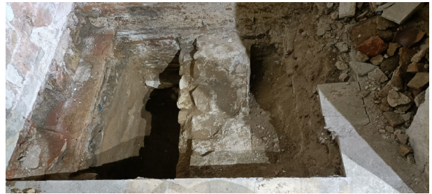
10. Vista general de cota final de Cala 2
